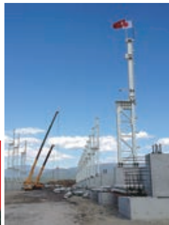
建設中の風景
